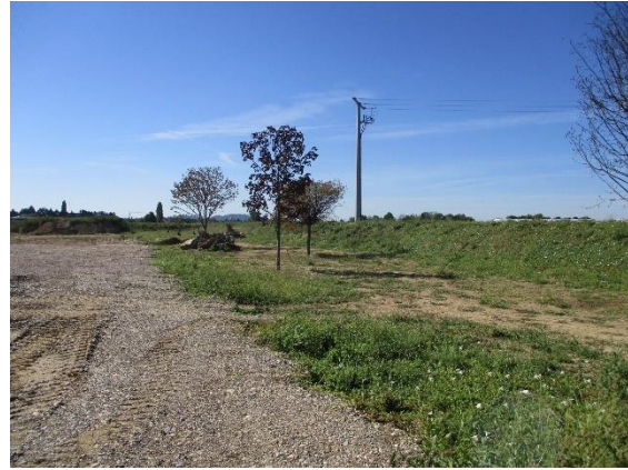
Abb. 8: Neu angelegter Erdwall, Baumpflanzungen und neu angelegte Habitatstrukturen am westlichen Rand des Plangebiets, Foto: faktorgruen, 25.08.2022
