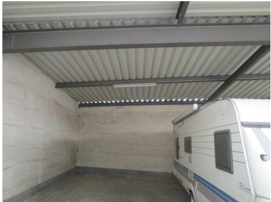
Foto 5: Innenansicht der östlichen Lagerhalle
