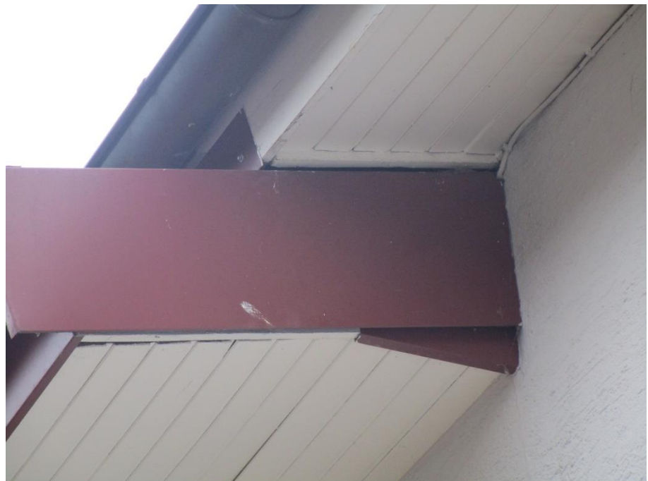
Foto 6: Dachüberhang von Halle zu Wohnhaus
