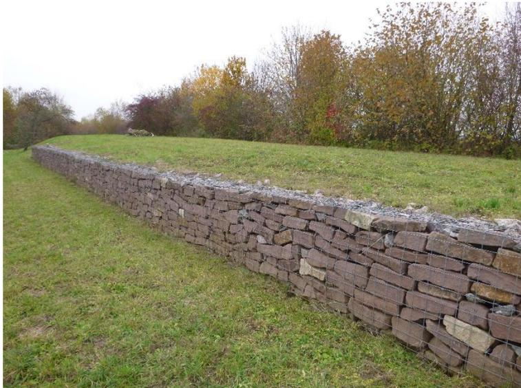
Abbildung 2: Beispielfoto Trockenmauer
