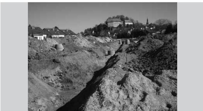
Im Saturn- und Siriusweg sind mittlerweile die Schmutzwasserhauptleitung samt Hausanschlüssen sowie Regenwasserhauptleitung ver-
