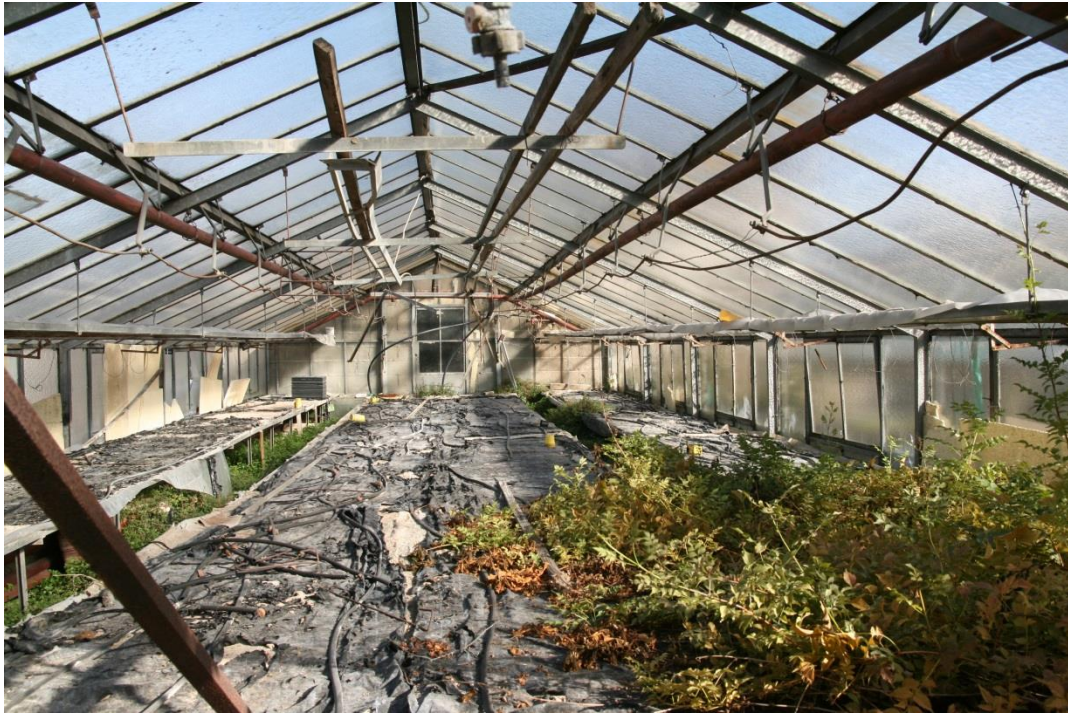
Abb.4: Gewächshäuser mit Restbeständen; Dachstuhl und Giebelseiten ohne Befund auf Fledermausquartiere oder hausbewohnende Vogelarten
